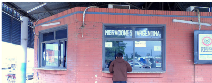
Puente San Ignacio de Loyola, Cabecera lado paraguayo. Control de ingreso de vehículos y peatones. Salida de Argentina (ventanilla al frente) e ingreso a Paraguay (ventanilla lateral).
